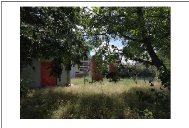
Трафо станица 20/0,4 kV
